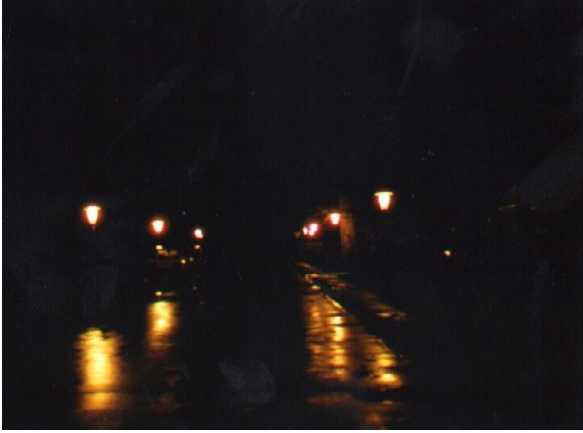
4. Razsvetljava na ulici Pod topoli v Ljubljani, je morda še uporabna za pešce, ki svoj pogled lahko odvrnejo od same svetilke. Voznikom pa zaradi bleščanja predstavlja bolj oviro kot pomoč.
