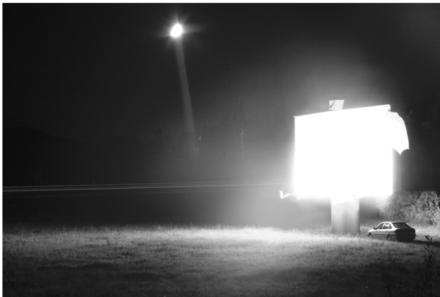
Slika 9: To ni več »jumbo« pano, to je svetlobno strašilo ob avtocesti. Več ton težka kovinska konstrukcija, velikosti 15 m x 6 m, dvignjena 3 m nad zemljo. Pano na posnetku je ob prometni tabli na avtocesti Trojane-Ljubljana blizu izvoza Krtina. Prometne table vozniki ne opazijo, saj svetlobno strašilo tako blešči, da zaslepi voznike. Osvetljenost panojev je 800 lx. Reflektorji onesnažujejo okolje več kilometrov daleč. To je nazoren primer izigravanja prepovedi reklamiranja ob avtocesti. Če ni dovoljen majhen napis ob avtocesti, se napravi desetkrat večjega, ki ji nekoliko bolj stran! Bo naslednji korak ta, da posekamo gozd ob avtocesti in pobočje prebarvamo v reklamne napise ter vse osvetlimo? Ali želimo živeti v takem okolju? Čemu čakamo z Uredbo o zmanjšanju svetlobnega onesnaževanja?
