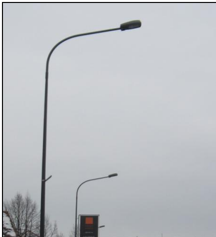
Slika 11: Nepravilno montirana zasenčena svetilka
