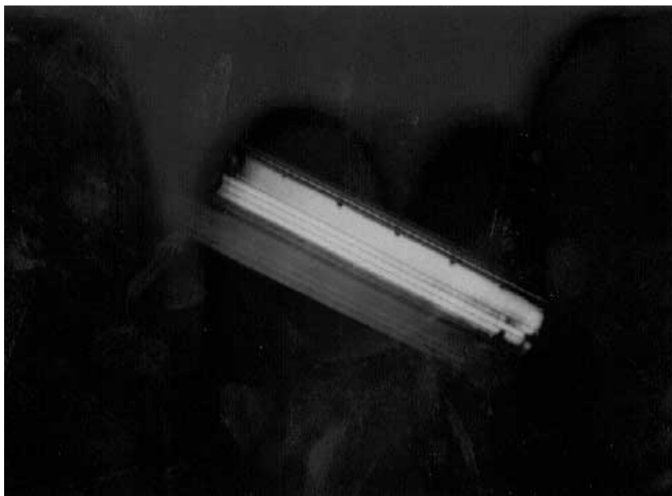
Slika 10: Ta svetilka je v smeri vožnje povsem zasenčena, uporablja pa tudi okolju in denarnici prijazen izvor svetlobe – nizkotlačno natrijevo sijalko. Želeli bi si več takih svetilk, ki odlično služijo svojemu namenu: povečanju varnosti na prehodu za pešce.
